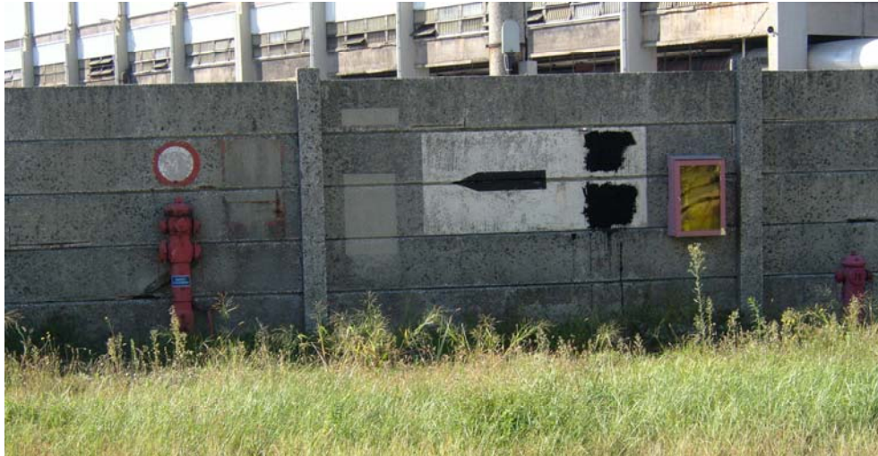
Figura 12 – Linea antincendio a tergo della banchina
